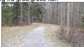
Bildene er eksempler på at gresset gradvis spiser seg inn på turveg og grusareal. Bredden blir smalere og kantene blir "visket" bort og fungerer ikke som ledelinje.
