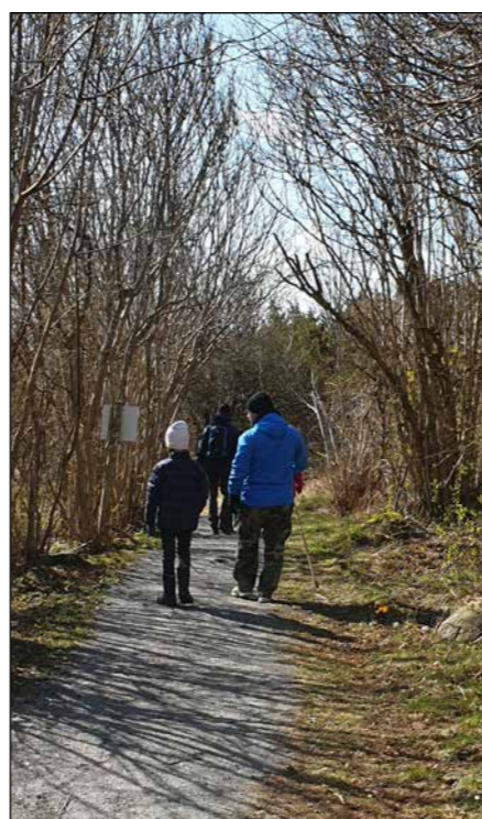
Bildene er eksempler på at gresset gradvis spiser seg inn på turveg og grusareal. Bredden blir smalere og kantene blir "visket" bort og fungerer ikke som ledelinje.
