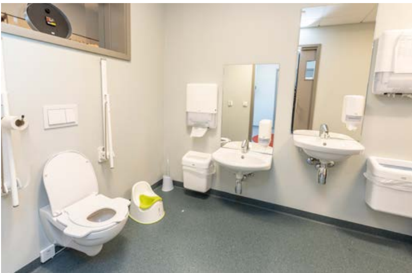
TRIPP TRAPP: Både wc og vasker er plassert i barnevennlig høyde. Døråpningen er trinnfri, og døren til å skyve.
